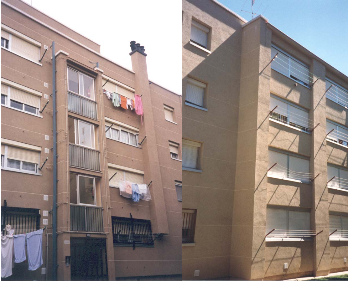
Figura 6.4. Fotografies de la façana principal i posterior rehabilitada del bloc tipus L1-4. Arrahona (Sabadell).
