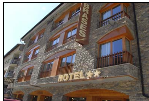
Fotografia 28: Detall de la façana de l'Hotel Les Brases. Font: Elaboració pròpia
