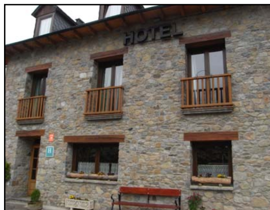
Fotografia 40: Hotel El Paller del Cisco Font: Elaboració pròpia.
