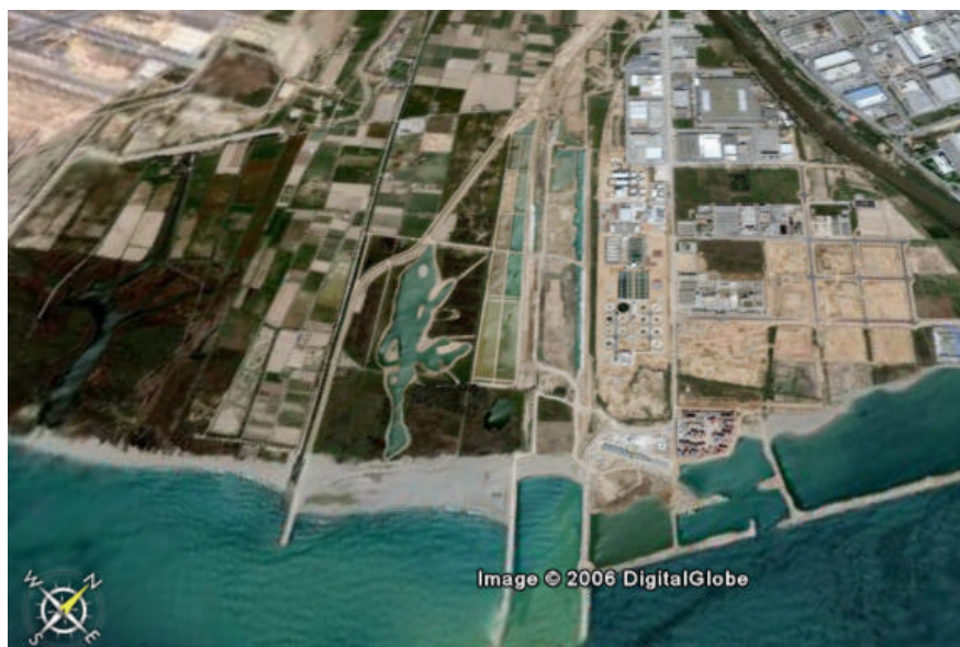
Figura 59: El delta del Llobregat a la nova desembocadura. Font: Google Earth, 2005.
