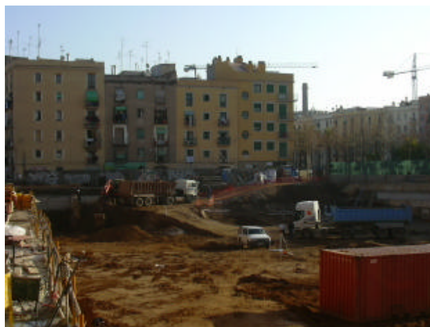
Figura 49: Projecte de transformació urbana a l'illa del carrer Robadors. Foto: Luis del Romero.
