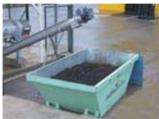
Fig. 8.4.1. Contenedor sin cerrar.
