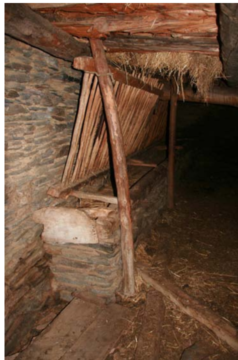
Imatge 3.5: Detall d'una menjadora i de l'obertura superior al paller. Font: elaboració pròpia
