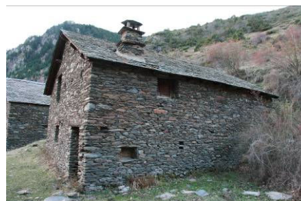
Imatge 7.2.5: Vista de la paret nord de la borda. Detall de la xemeneia
