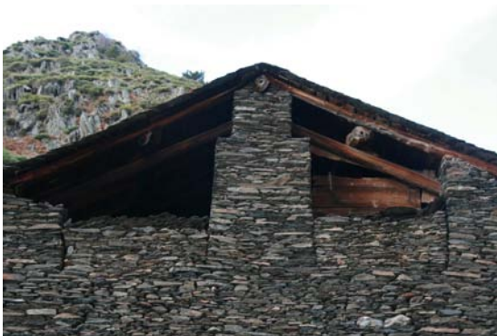
Imatges 3.10 i 3.11: Detall dels gaials del paller d'una borda. Font: elaboració pròpia
