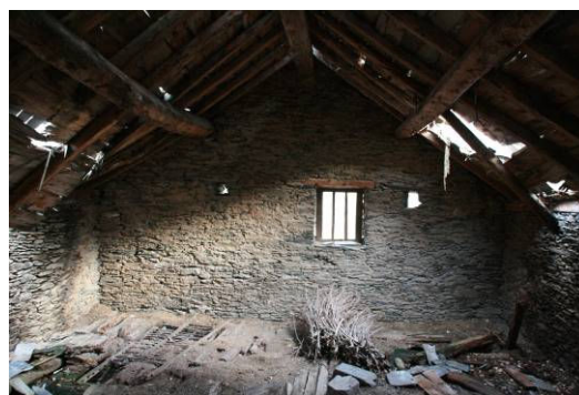
Imatge 7.4.13: Interior del paller de la borda
