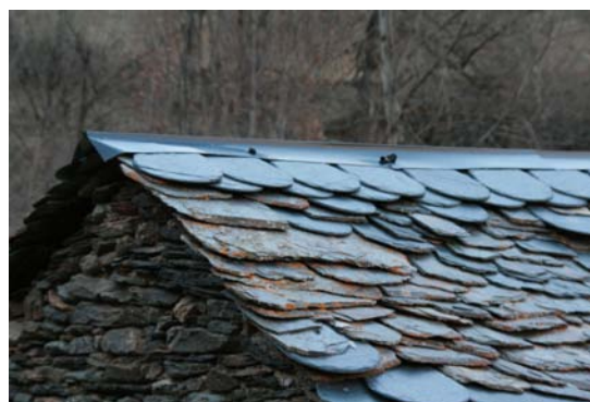
Imatge 7.2.7: Detall de la restauració de la teulada
