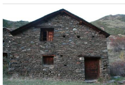
Imatge 7.2.4: Vista de la paret est amb porta i finestra de l'estable i finestra del paller
