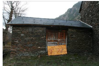
Imatge 7.2.25: Vista de la paret nord amb la porta del paller i vista de la teulada equipada per la neu
