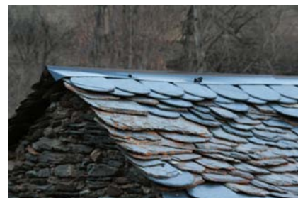
Imatge 7.2.15: Detall de la restauració de la teulada
