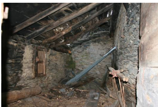
Imatge 7.4.15: Interior de la cabana i detall de la barra que aguantava la paret
