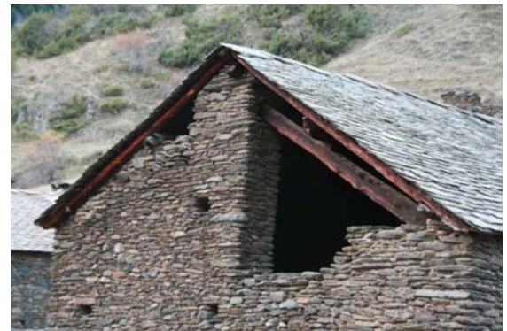
Imatges 3.10 i 3.11: Detall dels gaials del paller d'una borda. Font: elaboració pròpia
