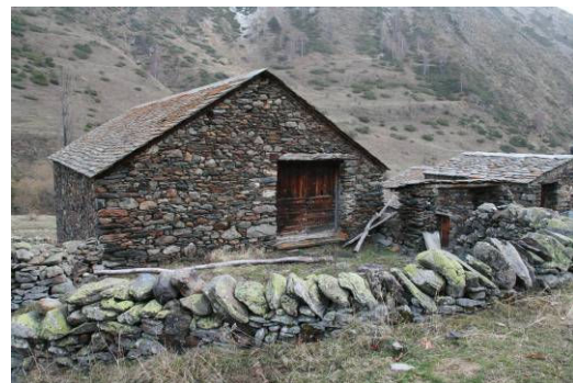
Imatge 7.3.7: Vista de la paret oest de la borda, porta del paller i mur de pedra seca que envolta la borda
