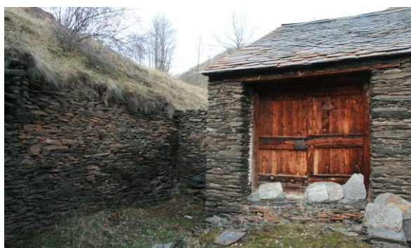
Imatge 7.4.20: Mur de pedra seca al voltant de la borda i vista de la porta del paller
