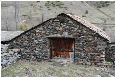
Imatge 7.3.12: Vista de la paret oest de la borda amb la porta del paller
