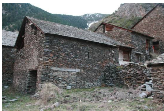
Imatge 7.2.18: Vista del mur a la part dreta de la fotografia unit a la paret de la borda
