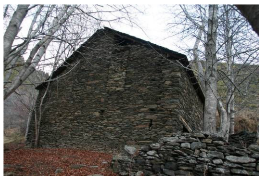
Imatge 7.1.7: Paret sud de la borda on s'observen els gaials tapiats amb pedres
