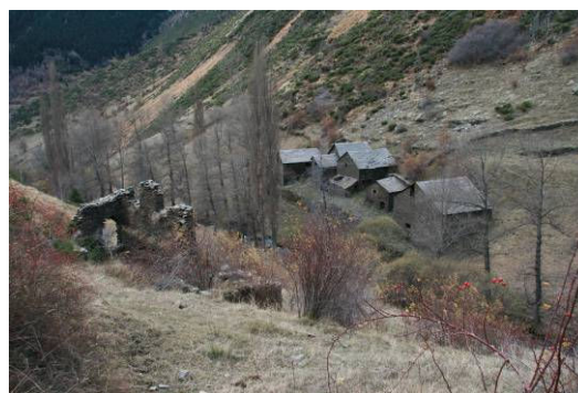
Imatge 7.4.3: Vista de la borda a la part esquerra de la fotografia i la resta de conjunt de clavillats a l'altre vessant de la vall
