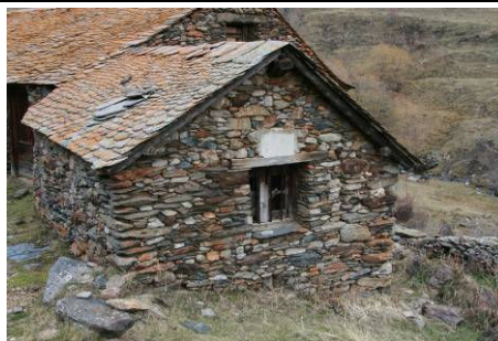
Imatge 7.3.29: Indicis del mur a la part dreta de la fotografia, i vista del forat a la teulada tapat amb lloses
