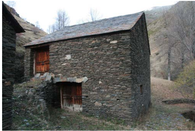
Imatge 3.6: Detall dels accessos diferenciats per al paller i l'estable. Font: elaboració pròpia
