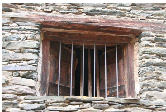
Imatge 7.4.19: Detall de la finestra remodelada amb barrots
