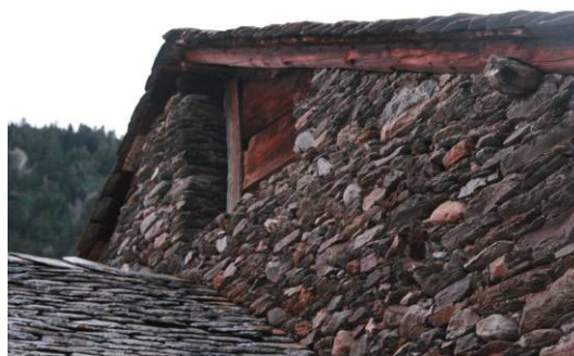
Imatge 7.2.20: Detall del gaial tapiat amb fustes
