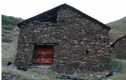
Imatge 7.2.14: Vista de la paret est de la borda amb el gaial i la porta de l'estable
