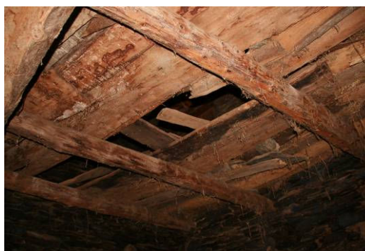
Imatge 7.5.2: Detall del terra del paller (Sostre de l'estable)
