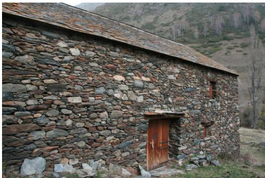
Imatge 7.3.6: Vista de la paret sud de la borda i de les portes i finestres en bon estat
