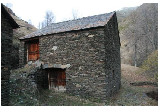
Imatge 7.4.18: Paret sud de la borda, vista de les portes del paller i de l'estable
