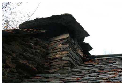
Imatge 7.4.17: Detall de la xemeneia de la borda
