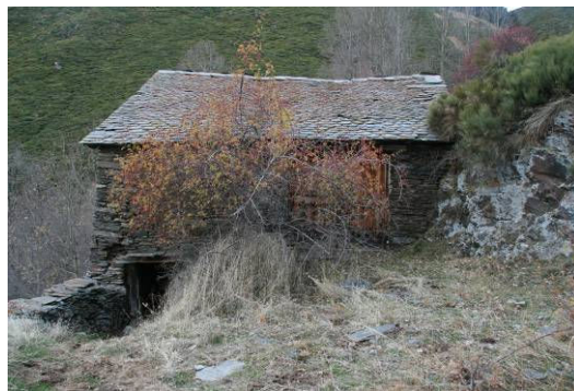
Imatge 7.1.2: Paret est de la borda. Vista de les portes del paller i de l'estable
