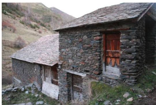
Imatge 7.2.19: Vista de la paret nord de la borda a la part dreta de la fotografia, i vista de la borda 7 a la part esquerra
