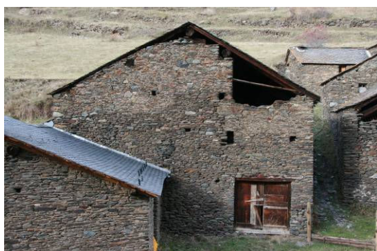
Imatge 7.2.21: Vista de la paret est de la borda amb la porta de l'estable, el gaial i els forats a la paret
