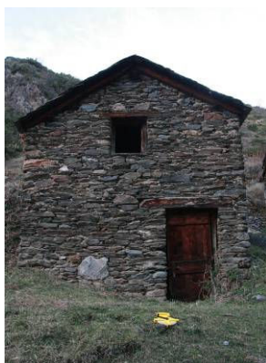
Imatge 7.2.28: Vista paret est amb la porta de l'estable i la finestra del paller
