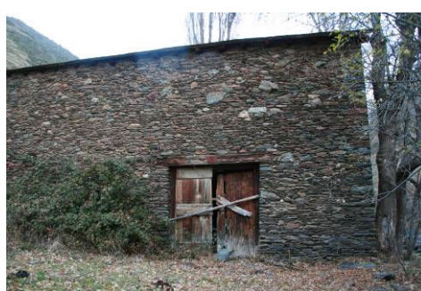
Imatge 7.2.3: Vista de la paret sud amb porta de l'estable tancada amb una barra de fusta
