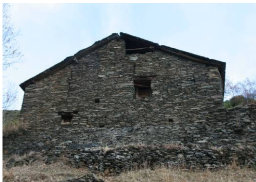
Imatge 7.1.1: Paret sud de la borda. Vista dels gaials, les finestres i els forats
