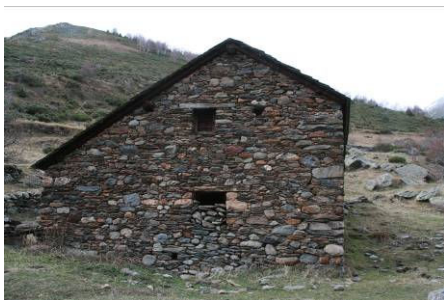
Imatge 7.3.2: Paret est de la borda, vista de la finestra del paller i la de l'estable tapiada
