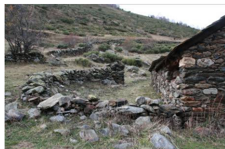
Imatge 7.3.5: Vista del mur de pedra unit a la borda
