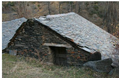
Imatge 7.4.11: Vista de la paret oest de la borda amb la porta del paller
