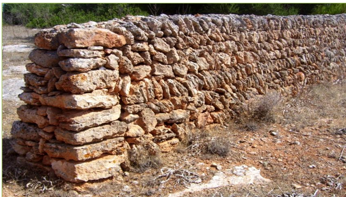
Imatge 7.11: Mur de paret seca en bon estat de conservació.
