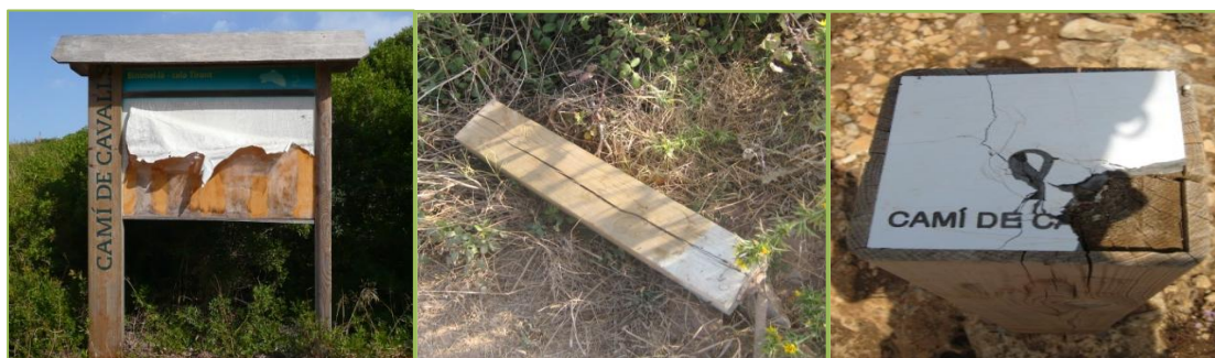
Imatge 14.2: Panell informatiu i fites del Camí de Cavalls deteriorats.
