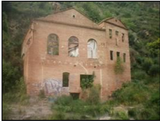
Figura II.71 : Imatge de l'estat actual de la central elèctrica de Riells, al peu de la vall.
