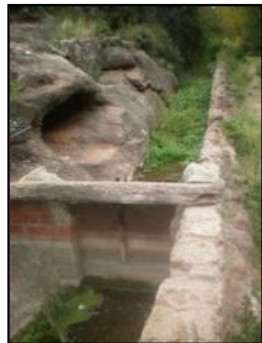
Figura II.72: Imatge de l'inici de la sèquia, al costat de la central elèctrica.
