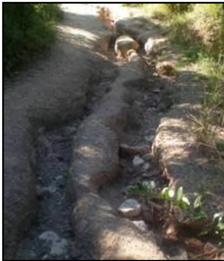
Figura II.8 : Imatge en la que es pot observar la pèrdua de sòl per escorrentia superficial, donant lloc a la formació de xaragalls en les vessants baixes dels cingles.
