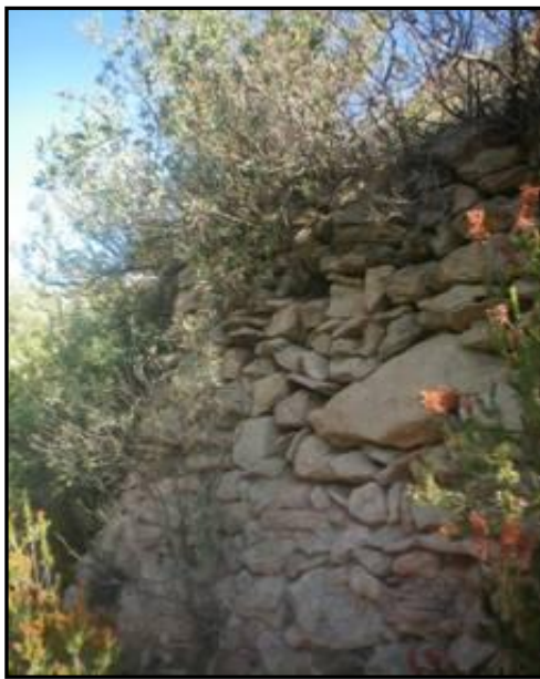
Figura II.69: Detall d'un tram de paret seca propera al camí de Sant Miquel del Fai. Autors: A.Bonàs i E. Carmona.
