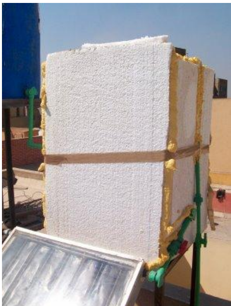
Caja hecha con poliuretano. La instalación se puede quedar así, aunque se puede decorar.
