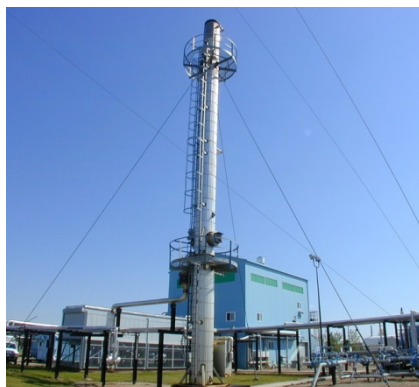
Figura 6.3. 2.- Imagen de la antorcha de tratamiento de gases.
