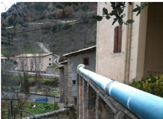
FIGURA: 5.3 Fotografies dels Canals de conducció d'aigua de l'antiga central minihidràulica.
