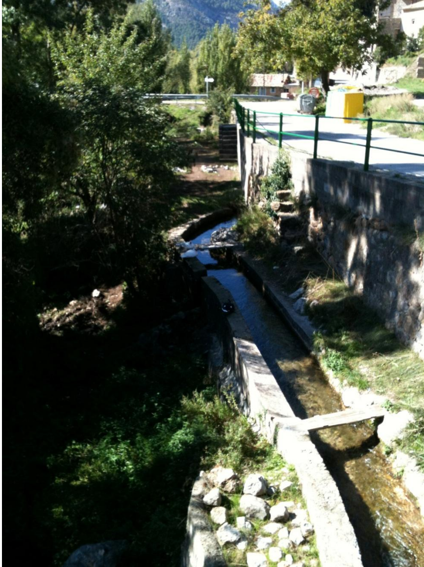
FIGURA: 5.4 Fotografies dels Canals de conducció d'aigua de l'antiga central minihidràulica.
