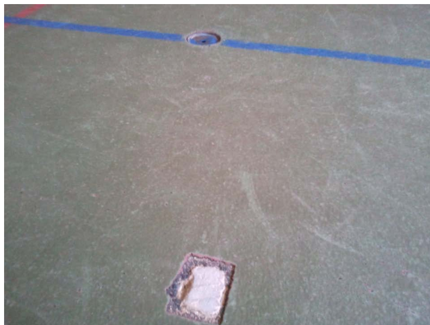
Millora 11: Eliminació forats de la pista
