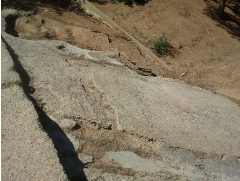
Millora 17: Igualar asfalt accés camp de futbol
