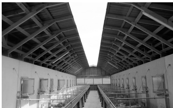
Figura 2. Paridera Naturland. Fuente: Jürgen Herrle. En la imagen se puede ver que los patios de esta paridera están totalmente cubiertos. En España, al no permitir unos patios totalmente cubiertos, los voladizos deberían ser más cortos para dejar una parte del patio descubierta
