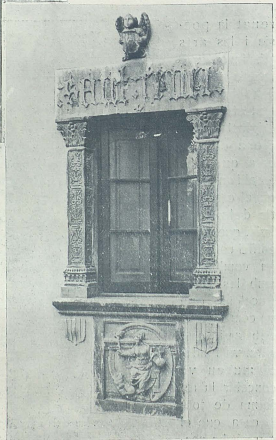
Finestra reconstruïda; jambes de terra cuita del palau de Don Martí; llinda de la torre de Canaletes a les muralles, i medalló de la sala de cà la Ciutat antiga de Barcelona.
