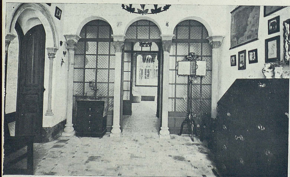
Un dels tres jocs d'arcs amb capitells antics que separen peces interiors
