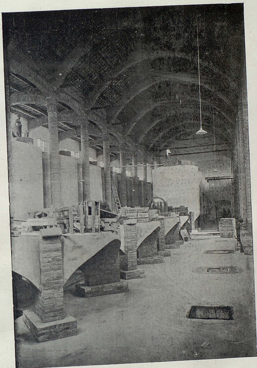
Celler de Sarreal. — Les tines en construcció
