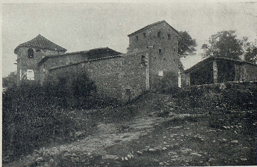
Masia de la Torra de Sant Medí.—Conjunt de la casa
