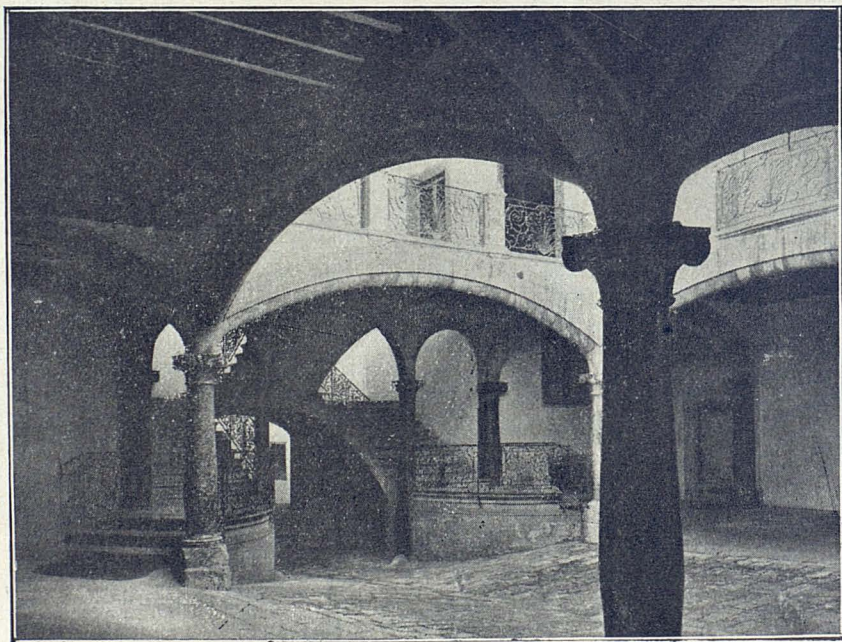
Altre aspecte del pati
