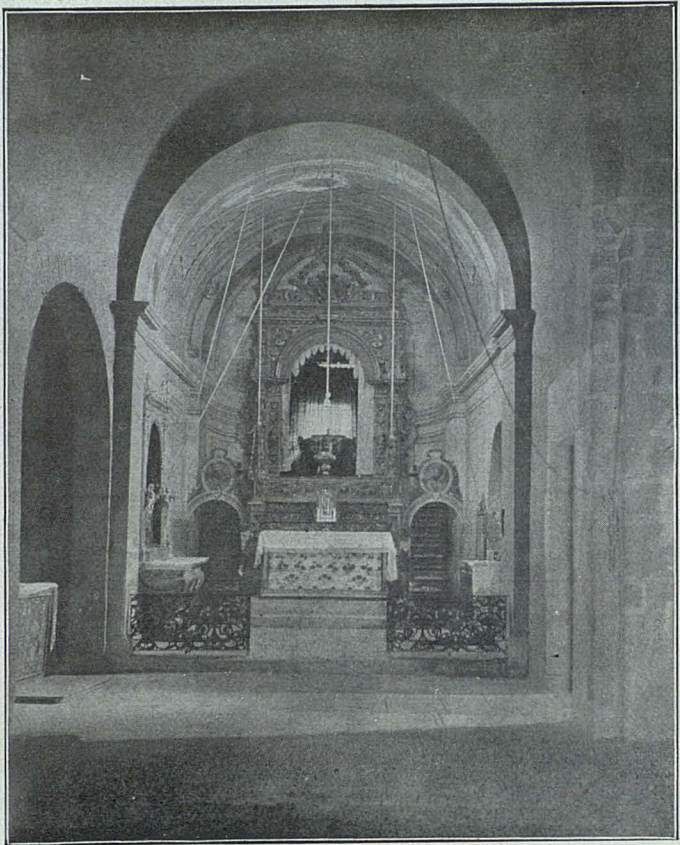
Interior de l'antigua església del castell
