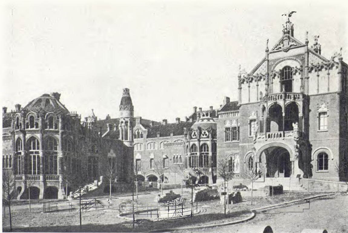
DETALL DE LA BALCONADA DEL ORFEÓ CATALÀ. - UNA VISTA DE CONJUNT DEL HOSPITAL DE SANT PAU.
