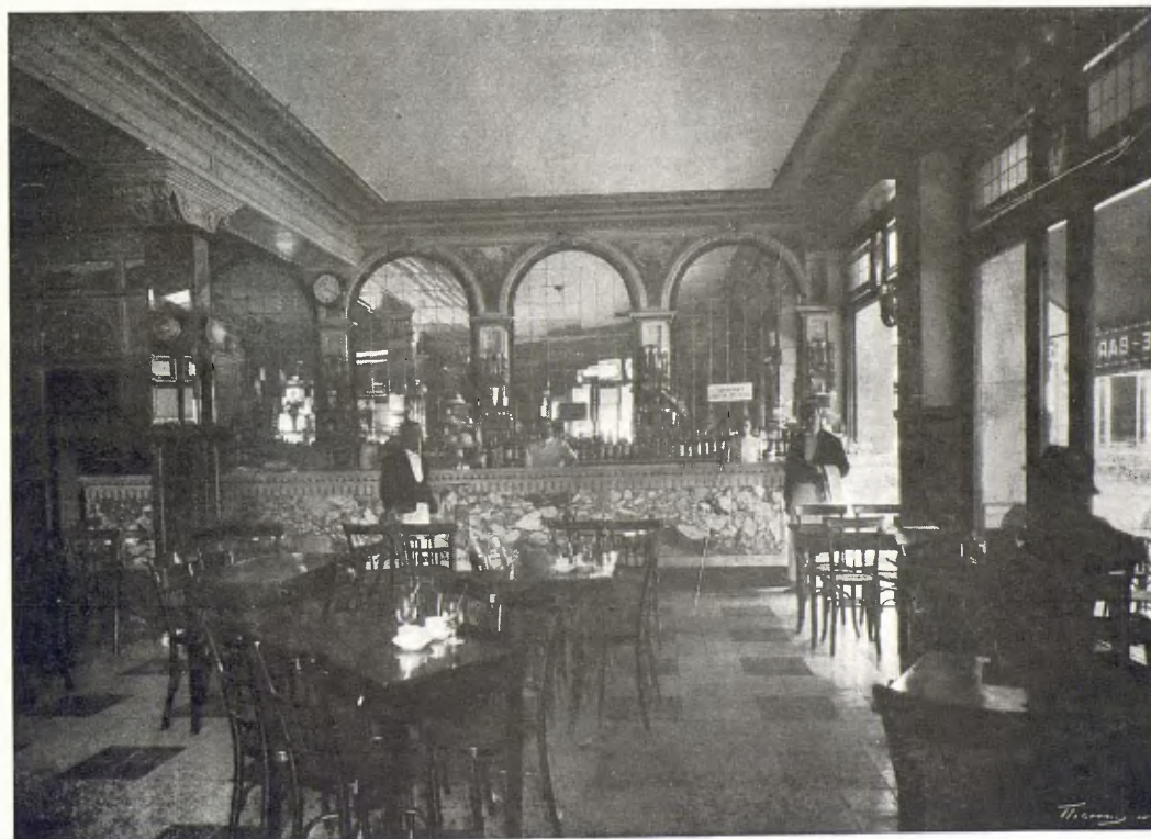
SALÓ DE BILLAR. - VISTA DE CONJUNT DEL CAFÈ "GRAN METRO". INSTALACIONS DIRIGIDES PER LA CASA "ALMACENES POMPEYA".
