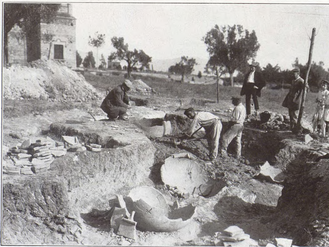
EXCAVACIONS A LA SERRA DE LA SALUT
