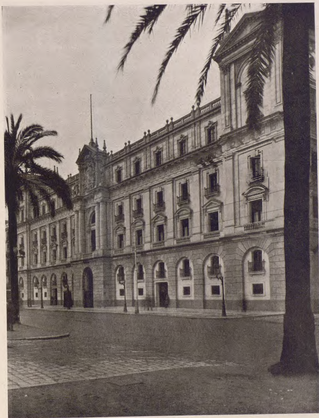
Façana de la Capitanía General. A. Florensa, arquitecte
