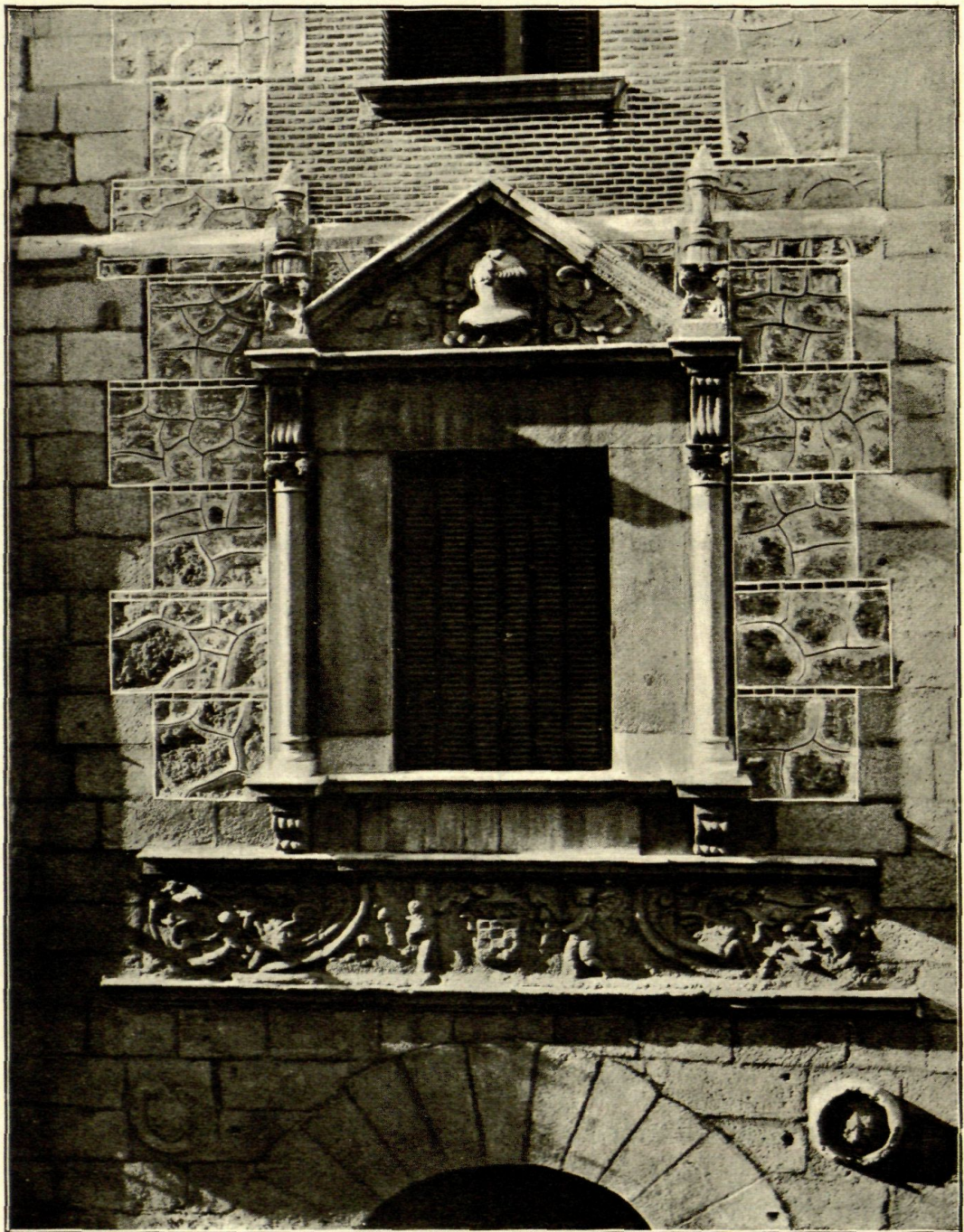
La casa de Cisneros.—Ventana primitiva, por la calle del Sacramento.
