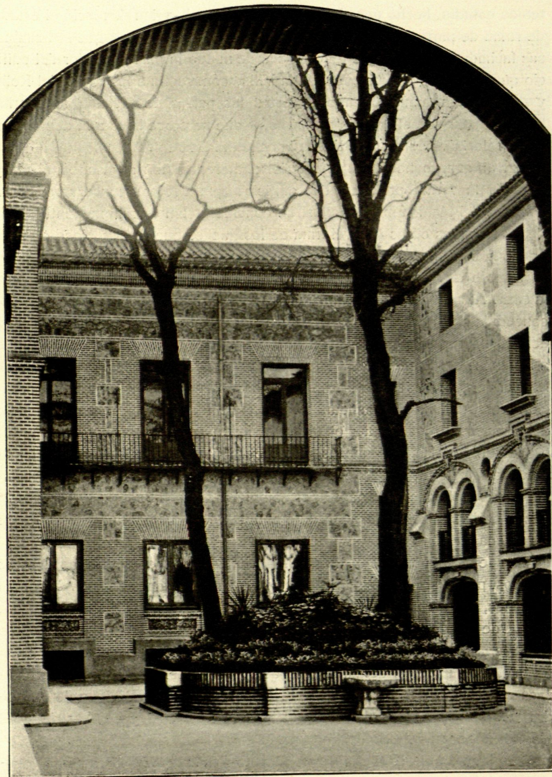
La casa de Cisneros.—Patio central. La fachada del frente está restaurada y reformada; la lateral derecha es de nueva construcción.
