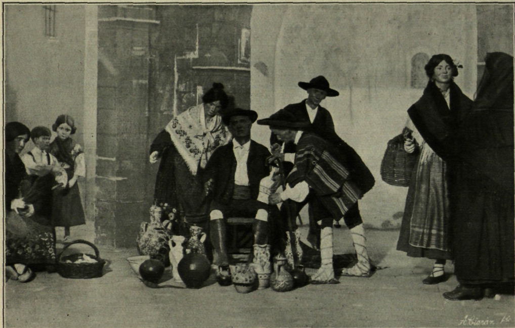
Instalación de Jaén (detalle).
