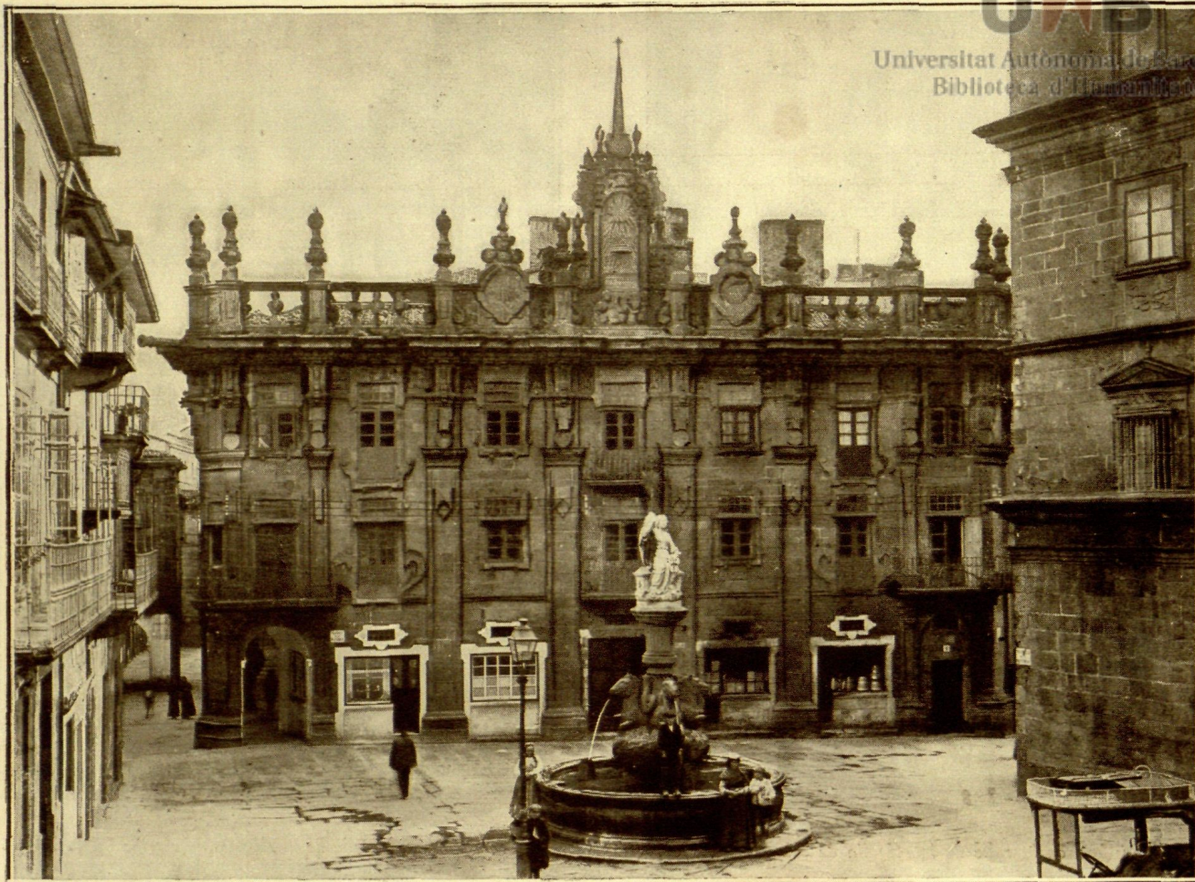
Fig. 6. a —Casa del Cabildo en la plaza de las Platerías.
