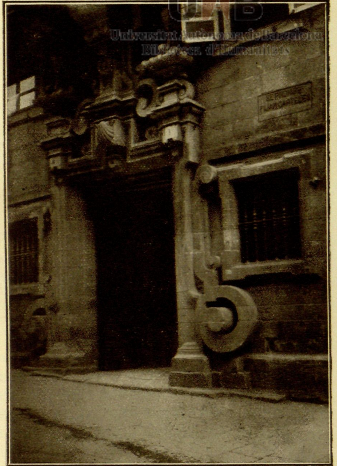
Fig. 7.ª—Casa del Deán (detalle de la portada).
