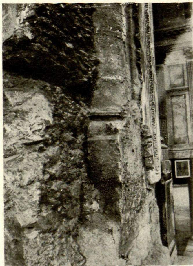
FIG. 8.—Fuste y basa góticos, ésta mutilada, descubiertos en uno de los arcos.
