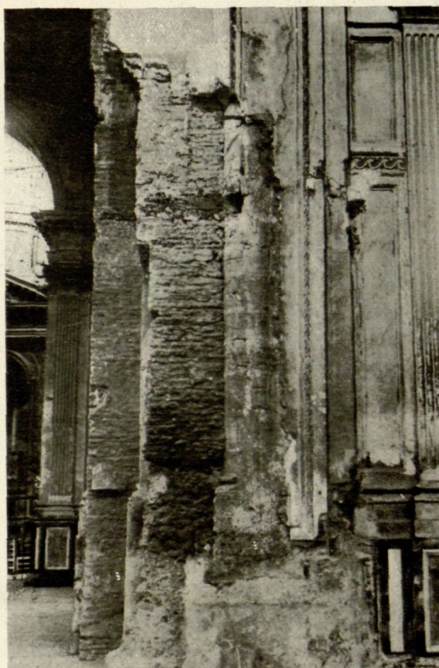
FIG. 11.—Columna geminada de uno de los arcos, con restos, a ambos lados, del mismo relleno.
