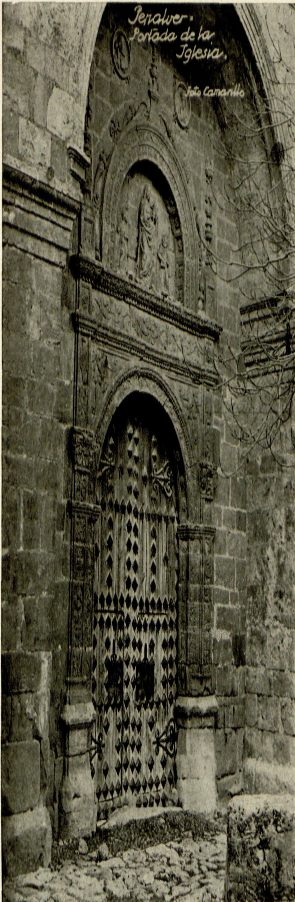
PEÑALVER.—Portada plateresca de la iglesia, obra de hacia 1530, probablemente debida a Covarrubias.
