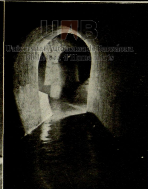
Colector Carcabón. Desviación bajo el "Metro" en la plaza de Colón.
