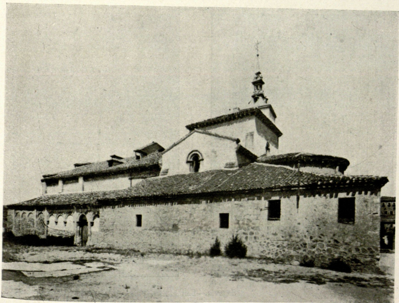
Segovia.—Iglesia de San Millán antes de su restauración.
