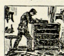
17 El ebanista contento fabrica muebles sin cuento.
