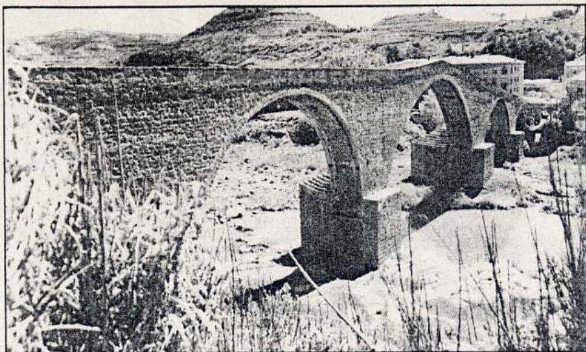
Figura 14: El Pont Vell de Castellbell i el Vilar després de la restauració, vist des del marge esquerre del Llobregat, aigües avall. Foto: J. Francès, 1987.
