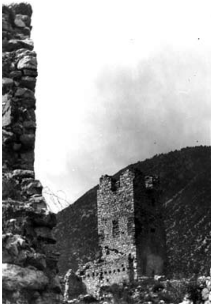
Vista de la torre del Castell de Gósol. ARXIU AJUNTAMENT DE GÓSOL
