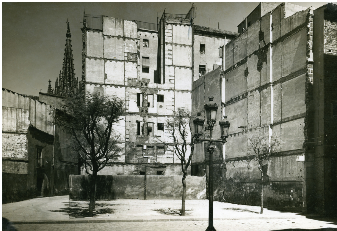
Figura 7 Fotografia de Francesc Ribera Colomer de l'any 1956, prèvia a la reforma de la plaça en la qual s'observa l'absència per enderroc de l'edifici corresponent a la façana D. [Font: Arxiu Fotogràfic de Barcelona]
