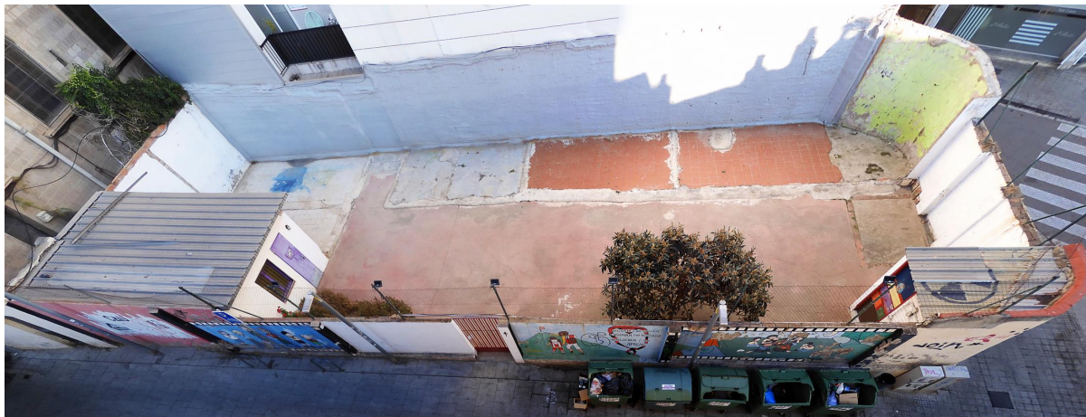
Pati del Cau ara, Passatge Penedès, Sant Feliu de Llobregat. / Foto: Marc Rius
