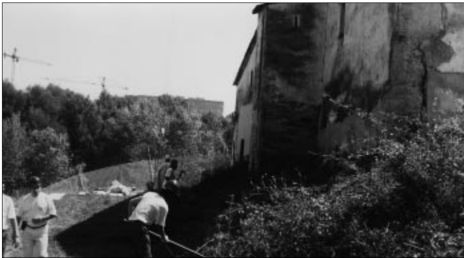
Han començat els treballs per rehabilitar la masia Can Miró.
