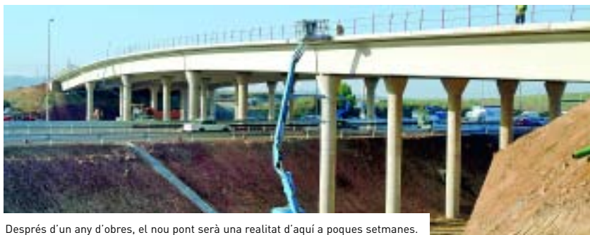
Després d'un any d'obres, el nou pont serà una realitat d'aquí a poques setmanes.
