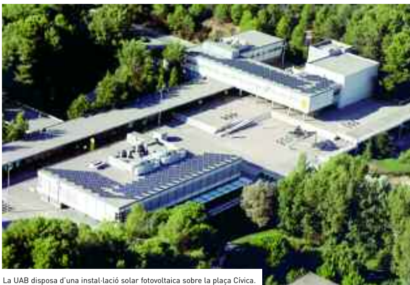
La UAB disposa d'una instal·lació solar fotovoltaica sobre la plaça Cívica.
