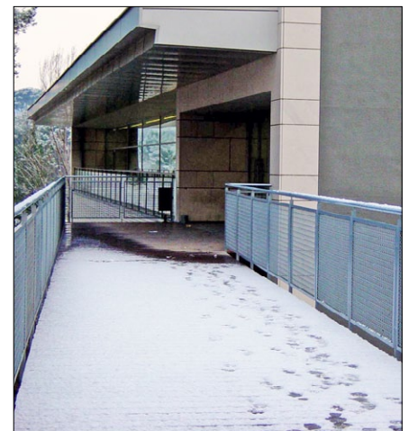
Neu al pont de la planta 4 (1/04/2003).
