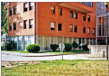
Exterior de l'Hemeroteca General. Edifici I (26/04/2000).
