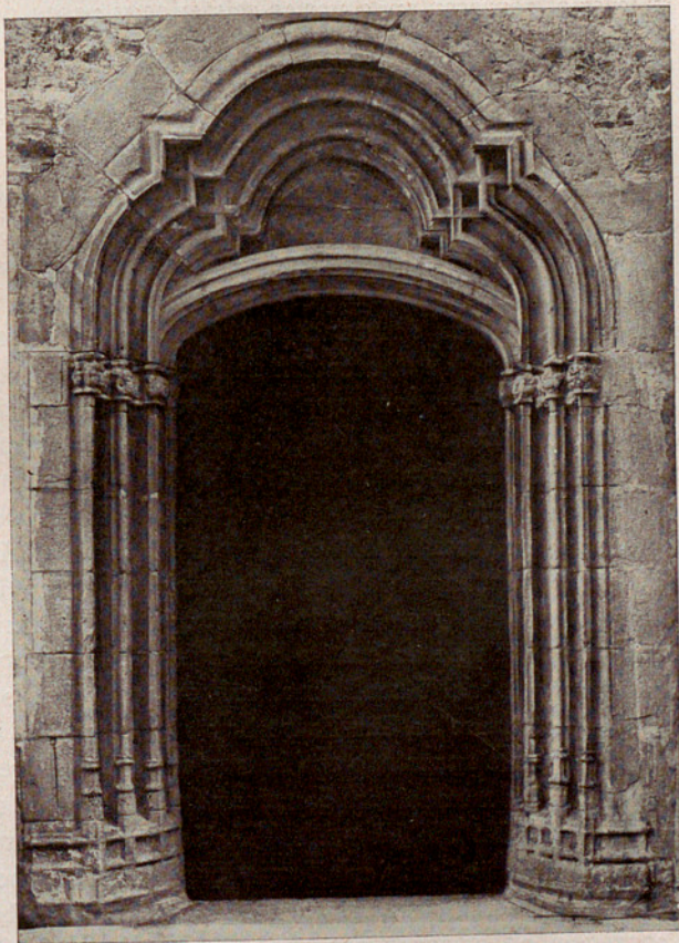
Uno de los portales de la antigua edificación.
