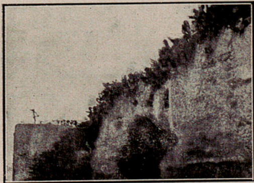
Torreón de la casa del Rey Moro
