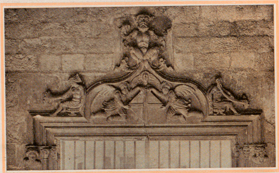
14 — DINTEL EN UNA PUERTA ENTRE PATIOS
