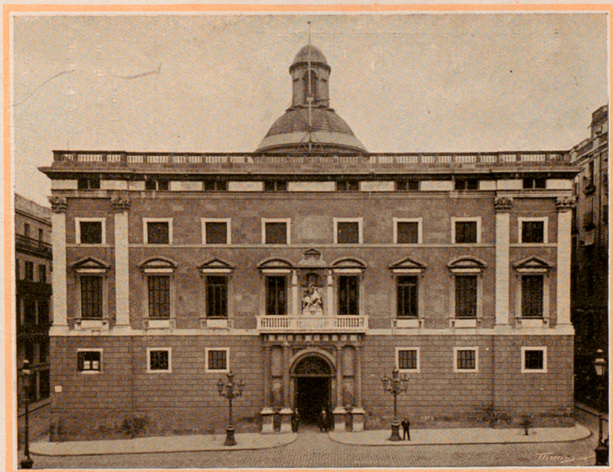
1 — FACHADA PRINCIPAL EN LA PLAZA DE LA CONSTITUCIÓN
