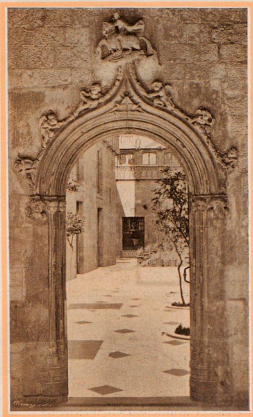
11 — PUERTA DE LA GALERÍA GÓTICA AL PATIO DE LOS NARANJOS
