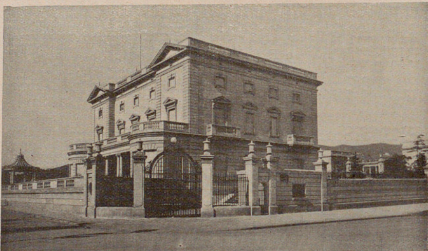
Edificio propiedad de la familia Durán Abadal, en cuyas fachadas de pared de piedra artificial se ha conseguido, al contemplarlas desde la Avenida de Alfonso XIII, la visualidad y todo el efecto de piedra natural que ofrece la casa.
