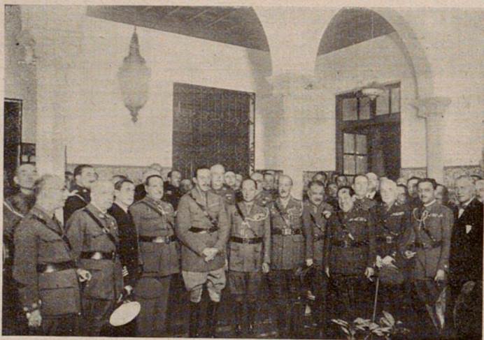
Visita de S. M. el Rey a Capitanía con motivo de las obras de reforma del edificio
