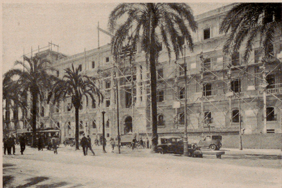
La fachada de la Capitanía durante las últimas obras de reforma
