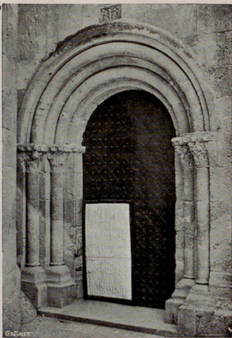
Puerta lateral, llamada «de Santa Tecla»
