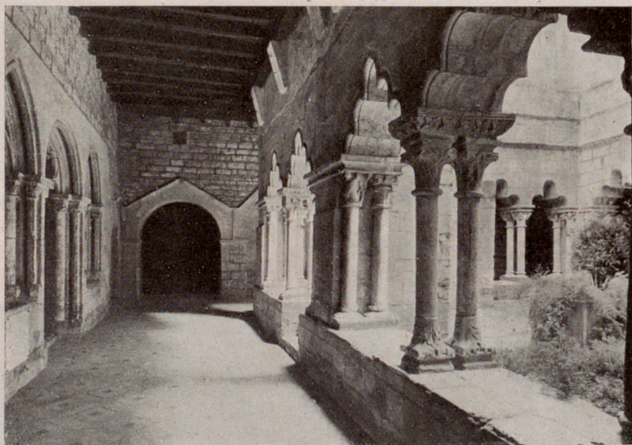
Claustro: La sala capitular al lado de la galería y al fondo la puerta que daba al refectorio.
