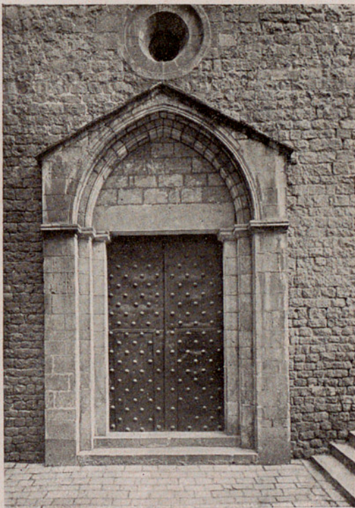
Puerta lateral que da paso al crucero.
