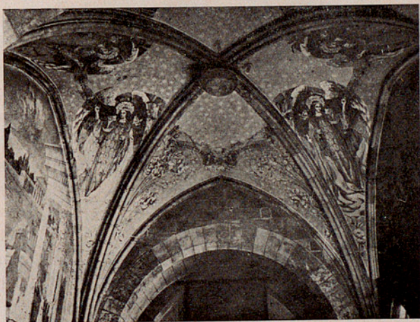
Iglesia: Bóveda de la ex-sala capitular.
