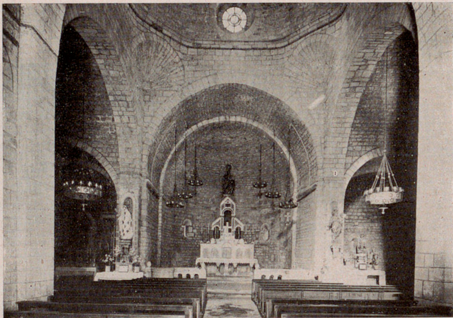
Iglesia: Interior de la nave y crucero.
