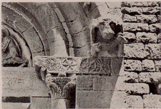
Puerta principal: Imposta y capitel visigóticos, con el buey simbólico de San Lucas.
