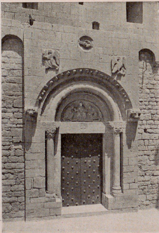
Puerta principal de entrada a la nave.
