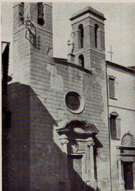
Iglesia del hospital de San Andrés (1790-95).
