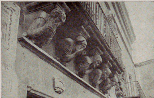
Detalle de las curiosas ménsulas de los balcones de la Casa Municipal.
