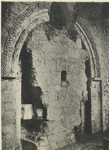
Puerta en la crujía Norte del claustro.
