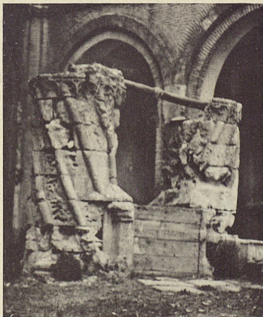
Pozo en el patio.
