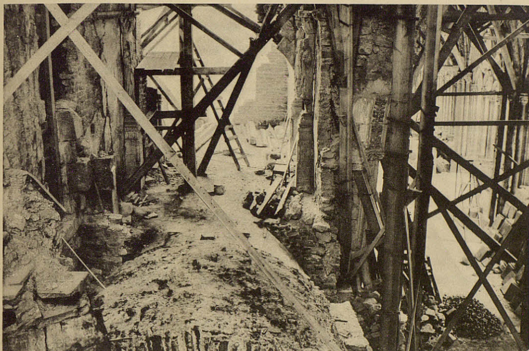
Asturias: Aspecto de las obras de Reconstrucción de la Cámara Santa en la Catedral de Oviedo en 1939.
