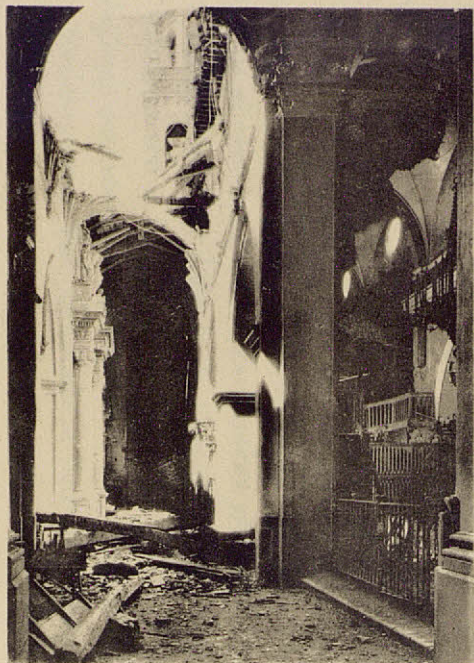
Estado en que fué hallado el interior de la Catedral de Teruel a la liberación de la ciudad
