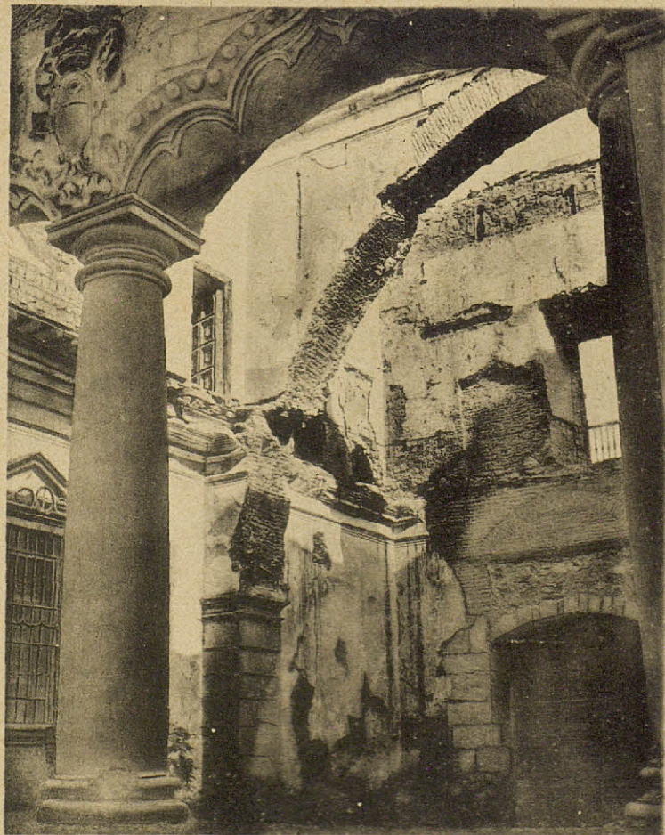
Arco de ladrillo construido por el quinto duque, para sostener la viguería del zaguán que hizo ampliar; estado actual.
