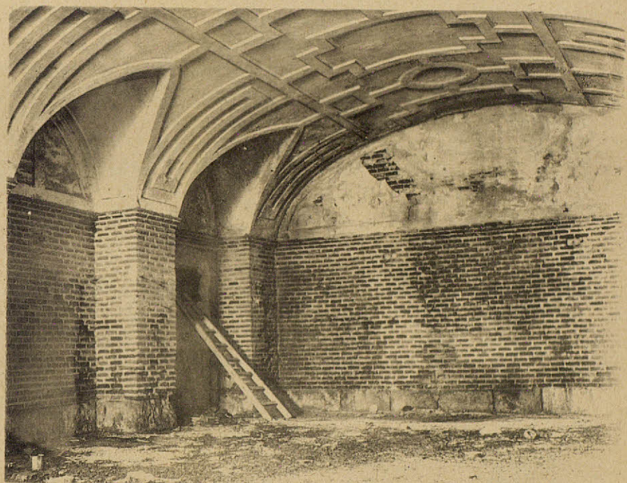
Habitación semisótano destinada a «botillería», con luces a la fachada principal.
