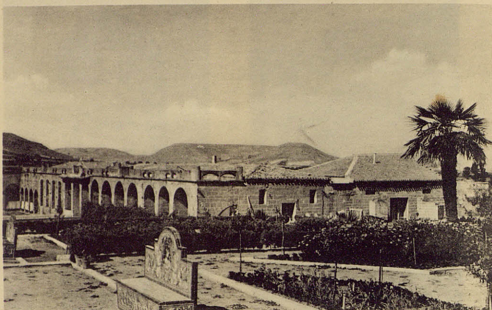
Estado actual de las obras de desenterramiento del Monasterio.
