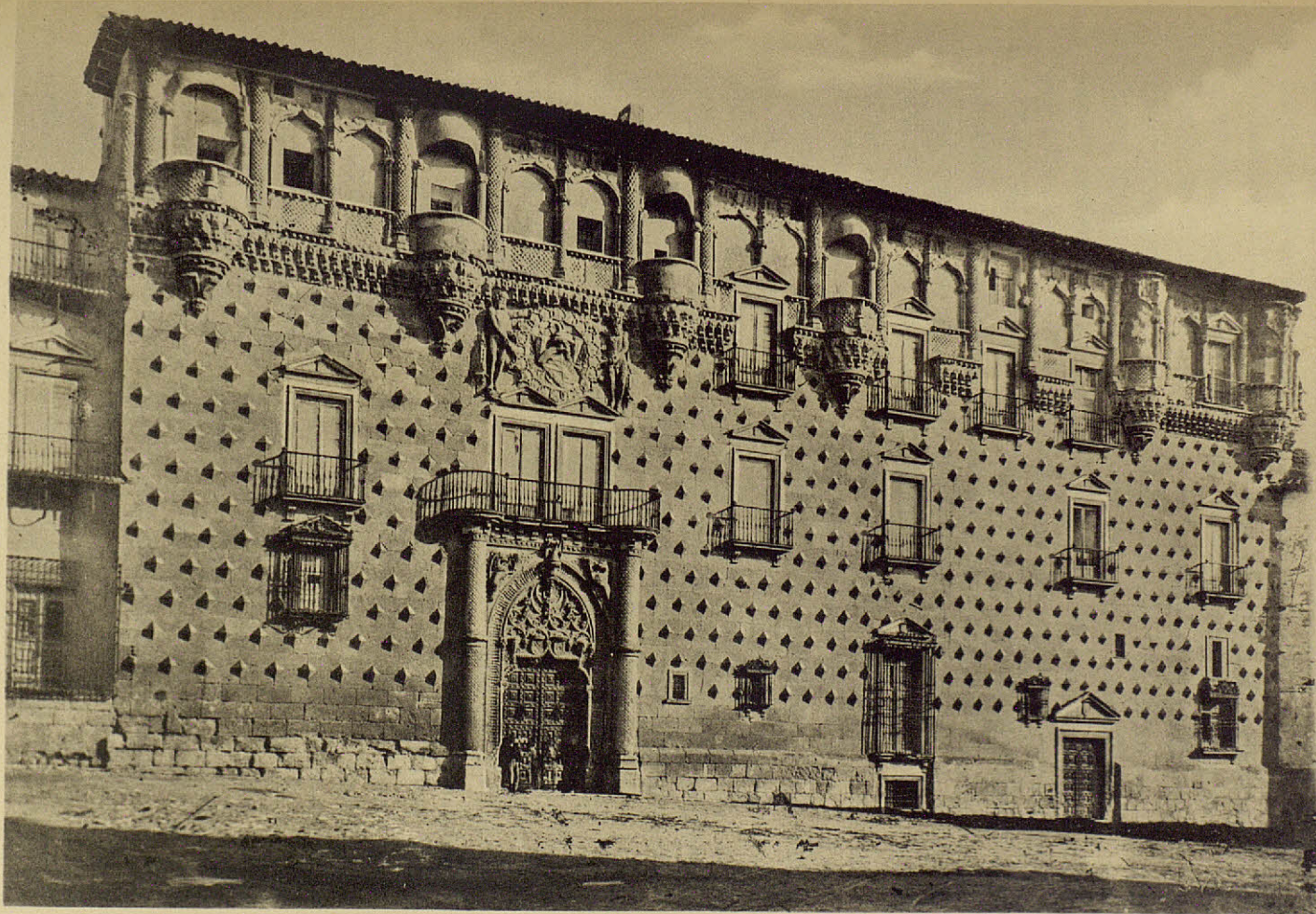
Fotografía de Laurent hecha hacia 1880; sin el jardinillo y verja actuales, pueden apreciarse en su conjunto y detalles todas las alteraciones y remiendos de que ha sido objeto la fachada del palacio del Infantado.
